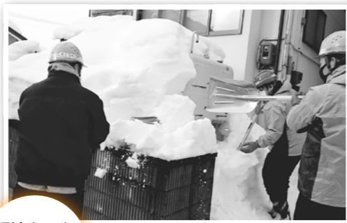
灯油タンク 付近の 掘り出し
