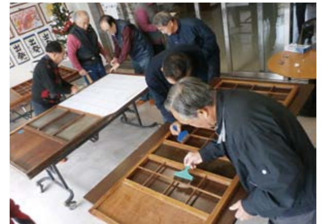
大小様々な障子を手際よく張り替えていきました
